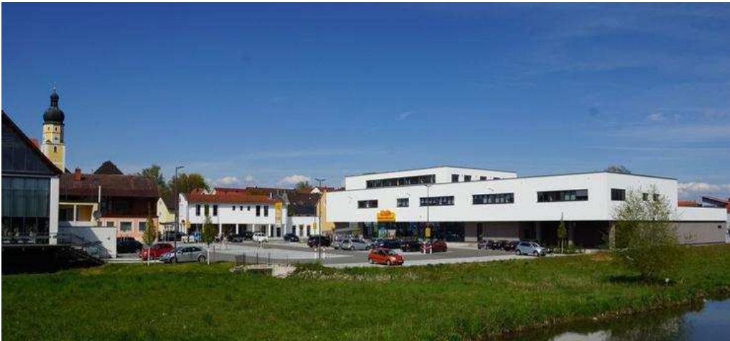
Das neue Geschäfts- und Bürgerhaus mitten im Ortskern von Schierling steht im Zentrum des Tages der Städtebauförderung. Foto: Wallner
